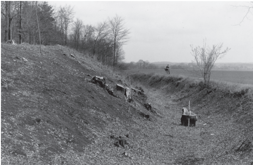
Abb. 13: Blick von Süden auf den Vorburgwall mit vorgelagertem Graben, Situation 1956 (Foto: Altertumskommission für Westfalen).
