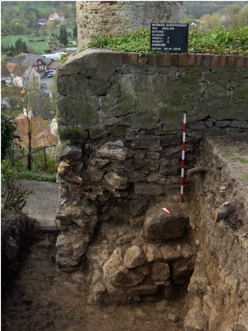
Abb. 20 Reste der mittelalterlichen Ringmauer im Bereich des Chattenturmes. Deutlich erkennbar ist die aufgesetzte Mauerwerkspartie, welche heute die Belegungsfläche des Burgplateaus begrenzt (Foto: LWL-Archäologie für Westfalen/M. Thede).
