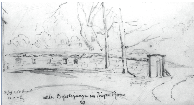
Abb. 20: Mauer und Reste der Landwehr vor dem Rieper Turm. 1,90 m hoch, 0,50 m stark und 61 m lang (Bleistiftskizze: Carl Dewitz, Lemgo 1880. Lipp. Lds. Bibl. Dt.).
