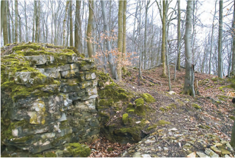
Abb. 22: Schacht im Bereich der mutmaßlichen Toranlage der Hauptburg (Foto: St. Brentführer, LWL-Archäologie für Westfalen).
