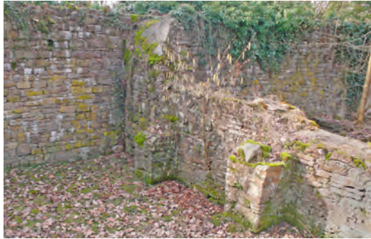
Abb. 22: Blick in das Gebäude 7 mit Strebepeilern aus Werkstein an der Westwand (Foto: R. Plöger).
