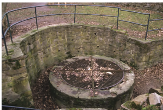
Abb. 20: Brunnen vor den Restaurierungsmaßnahmen (Foto: R. Plöger).
