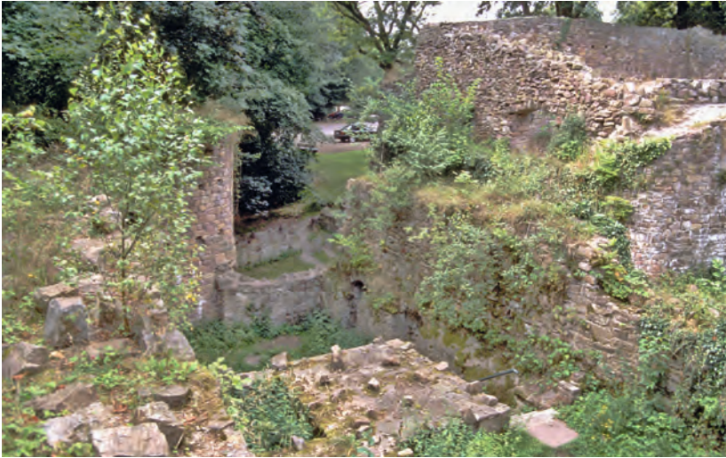
Abb. 13: Westtorbereich. Links Westturm, rechts „Palas“ (Foto: R. Plöger).
