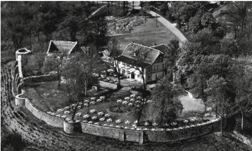
Abb. 8: Luftaufnahme der Burganlage von Südosten mit der 1884 errichteten Gastwirtschaft, Zustand um 1960 (Foto: Westdt. Luftfoto, Bremen).
