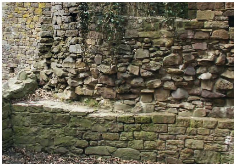
Abb. 14: Westtorbereich. Turm mit Resten der südlichen Zwingerwange (Foto: R. Plöger).
