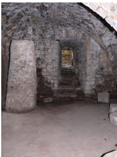
Abb. 18: Südwestseite des Palaskellers mit Säule unbekannter Funktion (Foto: R. Plöger).
