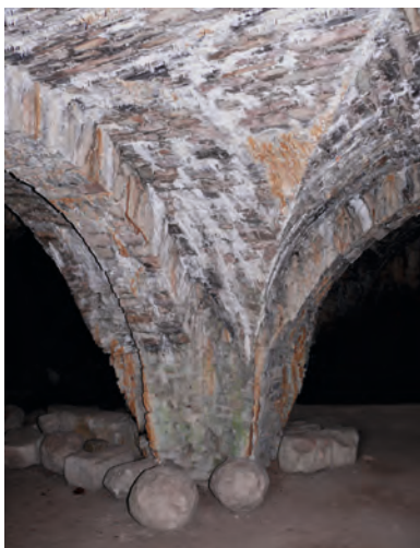
Abb. 17: Keller des „Palas“ mit Mittelsäule (Foto: R. Plöger).
