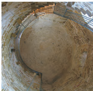
Abb. 25: Gewölbe des Bergfrieds über dem achteckigen Innenraum (Foto: St. Leenen, Essen).
