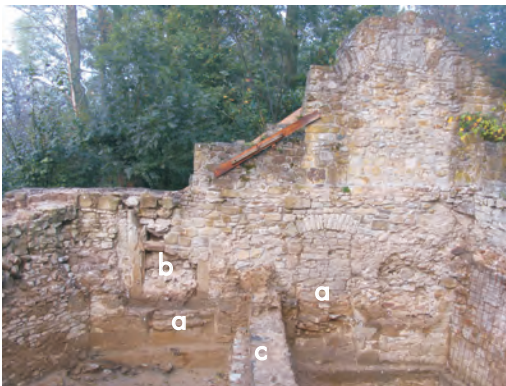
Abb. 15: Die Reste der Licht- und Luftschächte der ersten Hausphase (a), die später eingebrochene Tür (b) und die jüngere Trennwand (c) im Grabungsschnitt 2006 (Foto: St. Leenen, Essen).
