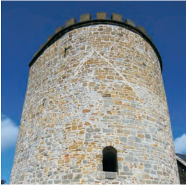
Abb. 20: Südseite des Bergfrieds mit Hocheingang und Giebelspuren (Foto: St. Leenen, Essen).
