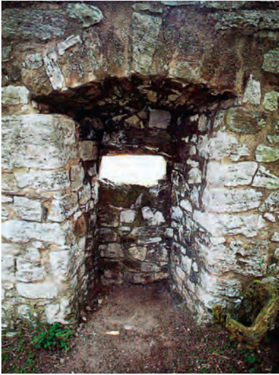
Abb. 21: Detail aus der Ringmauer im Süden der Hauptburg; Schießkammer als Spur militärischen Ausbaus (LWL-Archäologie für Westfalen/ R. Klostermann).
