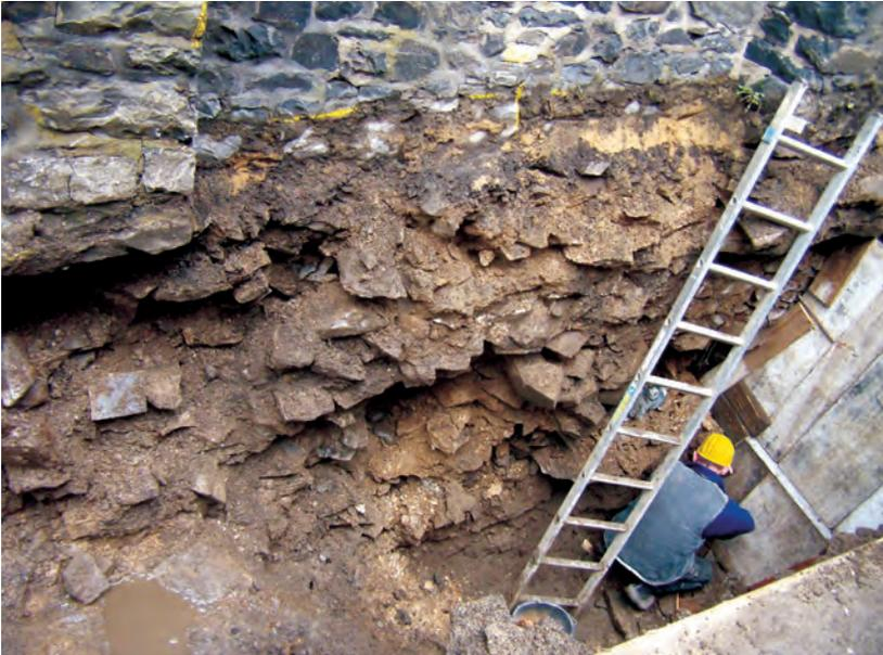
*Abb. 26: Ein Beispiel für die schlechte Fundamentierung der Außenmauer des unteren Burghofs während des Wiederaufbaus (Foto: St. Eismann, Münster).*
