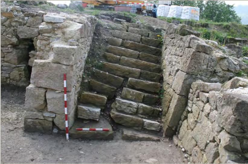
Abb. 10: Durch die Verfüllung des Brunnenschachtes und die Grabungen Ende des 19. Jahrhunderts sackte die Treppe eines Gebäudes der zweiten Nutzungsphase innerhalb der Vorburg massiv zur Seite (LWL-Archäologie für Westfalen/T. Pogarell).
