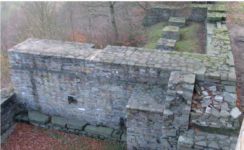
Abb. 20: Raum mit drei Pfeilerfundamenten, davor der Keller mit großem Fundamentblock in der rechten Ecke (Foto: St. Leenen, Essen).
