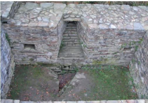
*Abb. 17: Keller im Westen der Vorburg mit einem ergänzten Schlitzfenster, Nischen und einer Wassersammelstelle (Foto: St. Leenen, Essen).*
