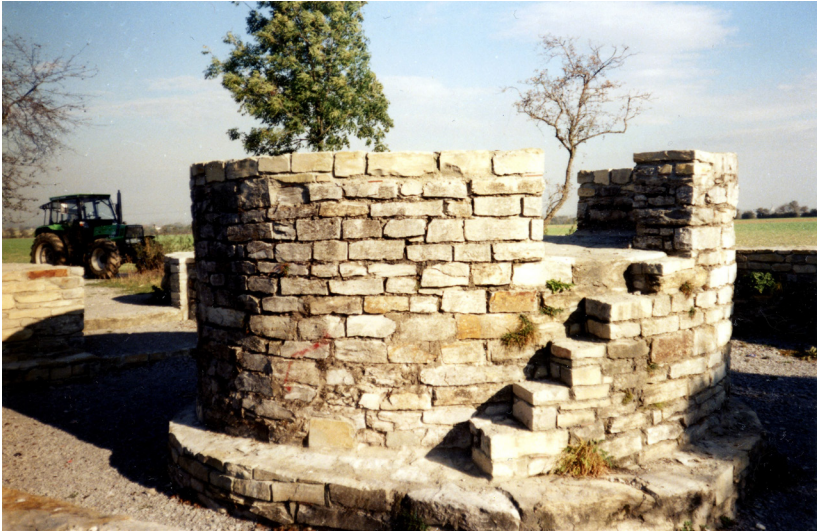
Abb. 16: Turmstumpf der Warte Lugdahl bei Renovierungsarbeiten im September 1989 (Foto: F. Budde).
