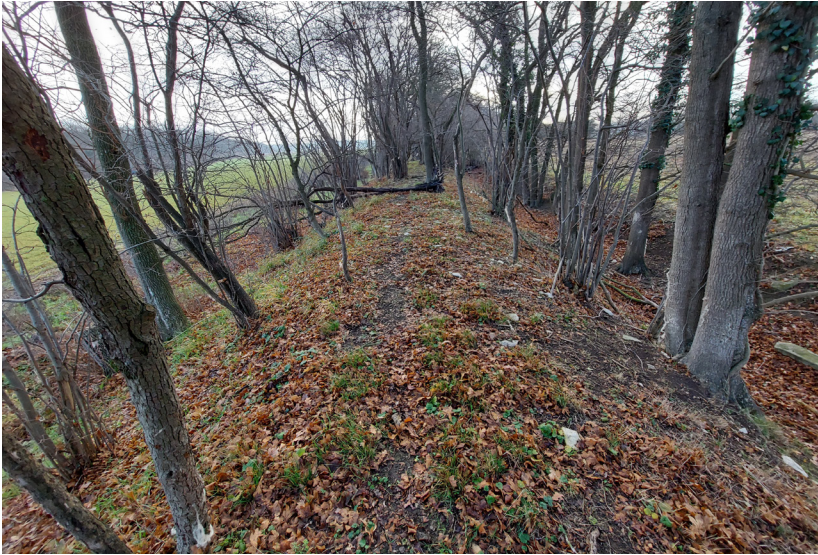
Abb. 5: Der Wall der Elsinger Landwehr (Foto: T. Sauerland).
