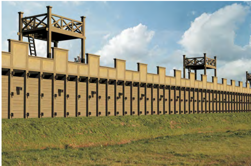
Abb. 23: Ansicht der Außenseite der Holz-Erde-Mauer (Vorlage: K. Peterse, Pansa BV, Nijmegen).
