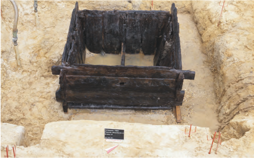
Abb. 20: Kastenförmige Holzverschalung eines nahe beim Militärbad gelegenen Brunnens. Der Erhaltungszustand des Eichenholzes erlaubte eine präzise Altersbestimmung (Foto: J.-D. Ludwig, LWL-Archäologie für Westfalen).
