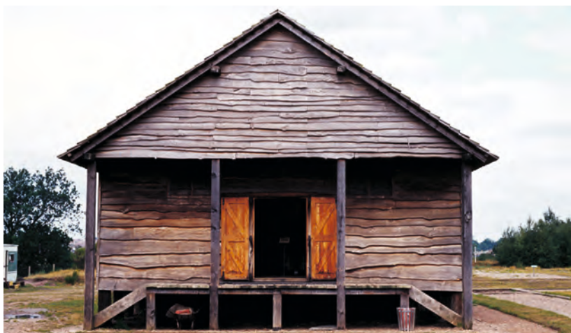
Abb. 25: Wie ein römischer, in Holzbauweise errichteter Speicher ausgesehen haben könnte, zeigt diese Rekonstruktion aus dem Römerlager in Baginton (The Lunt), England (Foto: J.-S. Köhllborn, Saerbeck).
