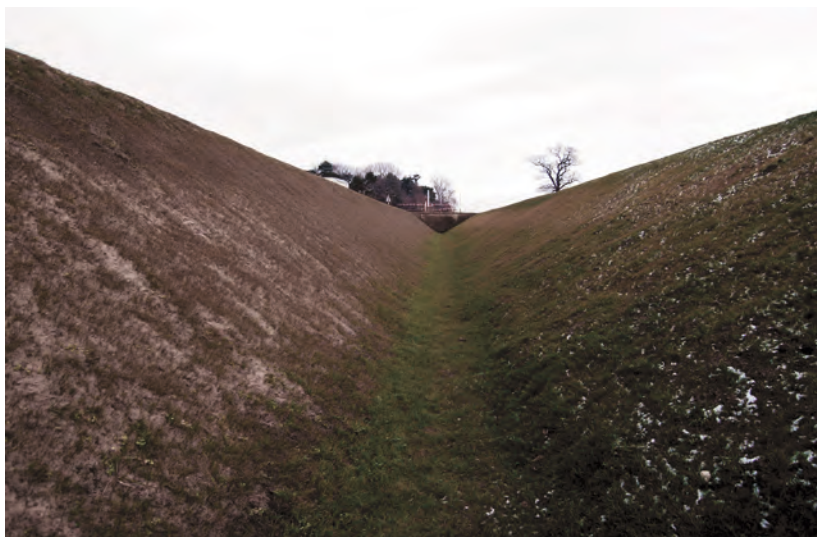
Abb. 32: Wiederhergestellter Wehrgraben westlich des Südtores (Foto: J.-S. Kühlborn, Saerbeck).
