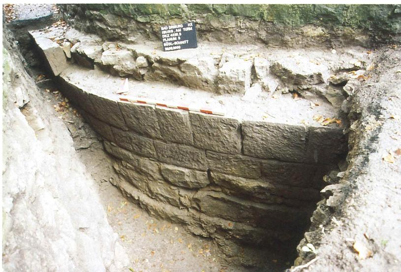
Abb. 9: Zwei erhaltene Lagen der äußeren Sandsteinschale des Bergfriedes waren durch eine Grabung nachweisbar. Darunter beginnt das Fundament des Turmes aus grob zurechteten Bruchsteinen (Foto: T. Meglin, WMfA).
